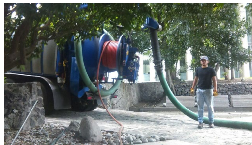
Ilustración 6. Trabajos de desazolve de pozos de absorción
