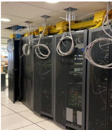
Site de la Coordinación de Servicios de Cómputo
