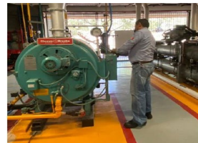
Foto no. 2 Mantenimiento a caldera
