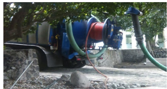
Foto no. 7 Trabajos de desazolve de pozos de absorción y líneas de drenaje
