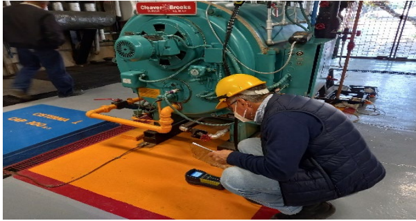
Foto no. 2 Mantenimiento a caldera
