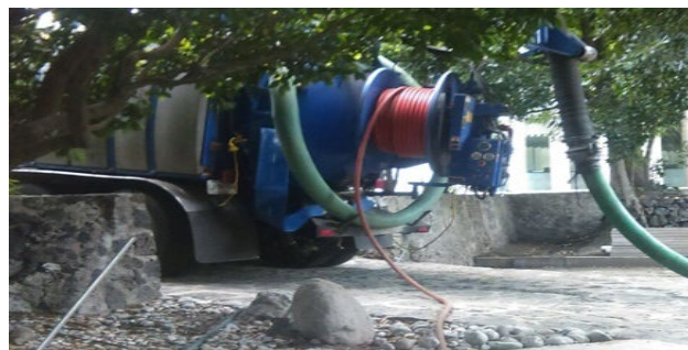
Foto no. 8 Trabajos de desazolve de pozos de absorción y líneas de drenaje
