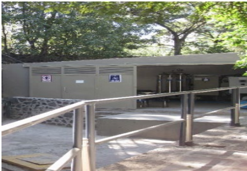
Foto no. 4 Planta de tratamiento de aguas residuales
