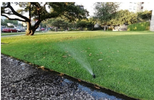
Foto no. 4 Sistema automatizado para el riego de áreas verdes con agua tratada
