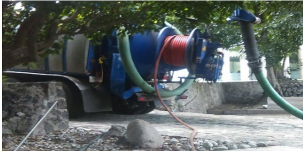
Trabajos de desazolve de pozos de absorción
